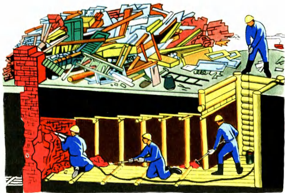
Устройство галереи в завале
