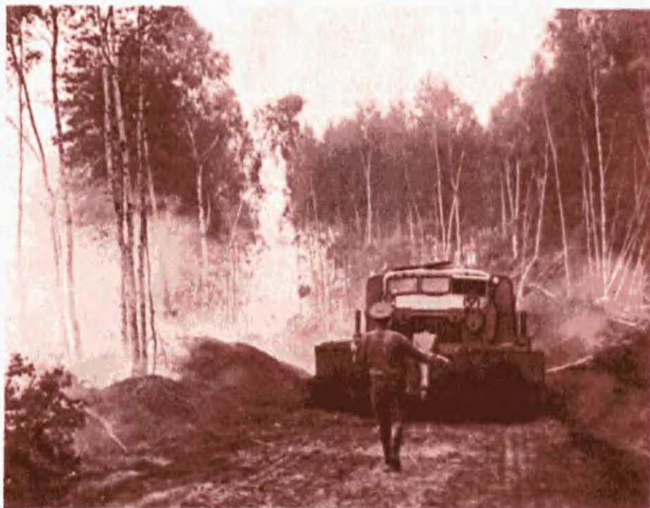
Прокладка минерализованной полосы в очаге лесного пожара. За 1 ч бульдозером можно проложить 1000—1200 м заградительной полосы
