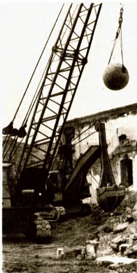
Применение стального шара для обрушения конструкции, грозящей обвалом
