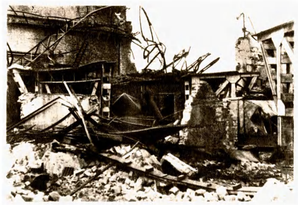
Общий вид завала на разрушенном промышленном объекте
