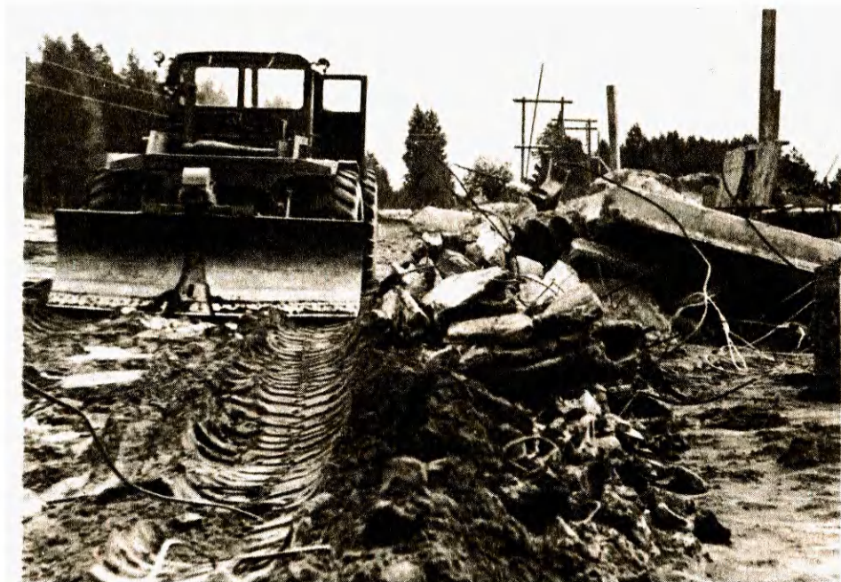
Использование бульдозера на пневмоколесном ходу при устройстве проезда в завале
