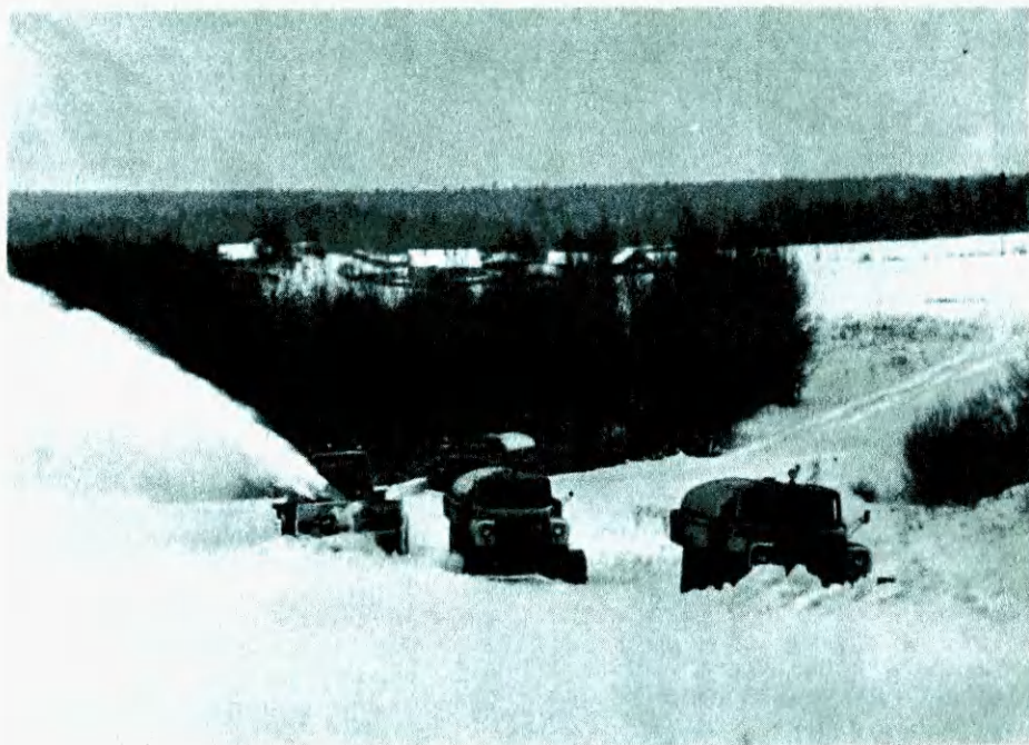
Снегоочистительные машины целесообразно использовать группами, например, 2—3 бульдозера или бульдозер и роторный снегоочиститель
