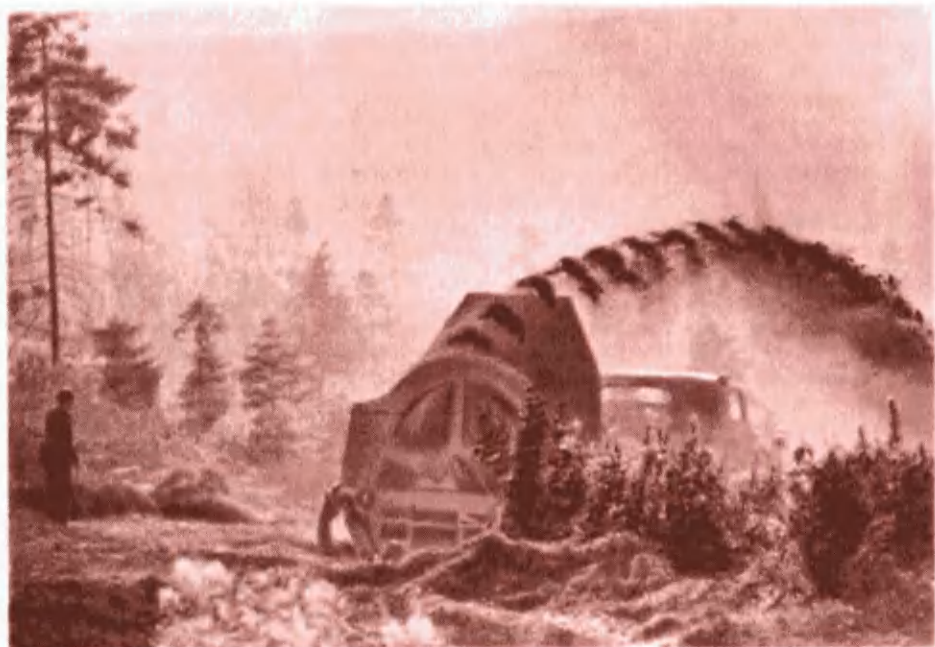
Устройство минерализованной заградительной полосы машиной для отрывки котлованов
