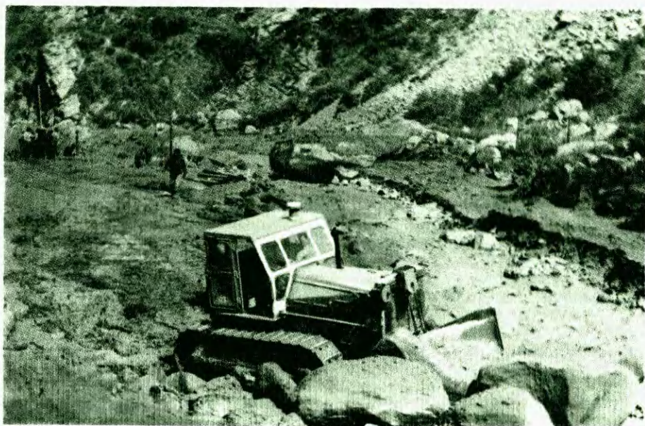
Ремонтно-восстановительные работы после прохождения селя
