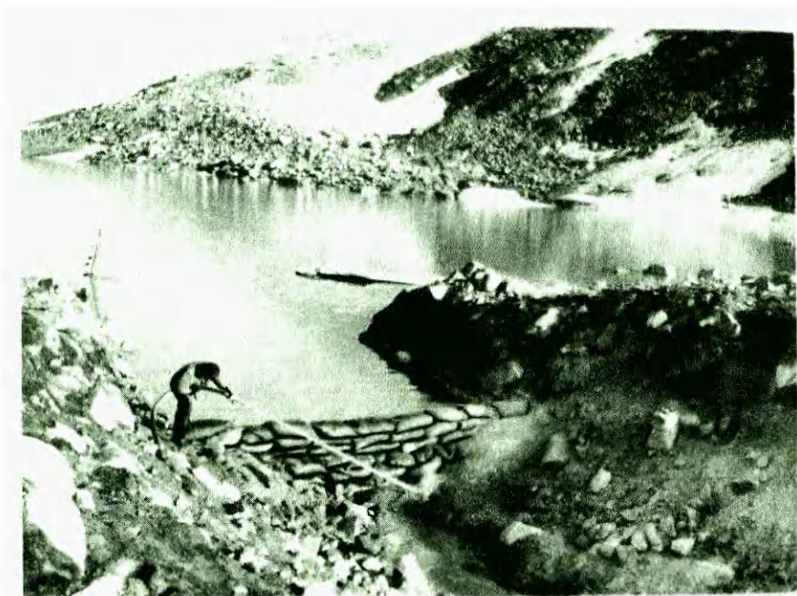
Удаление взорванной породы гидравлическим способом
