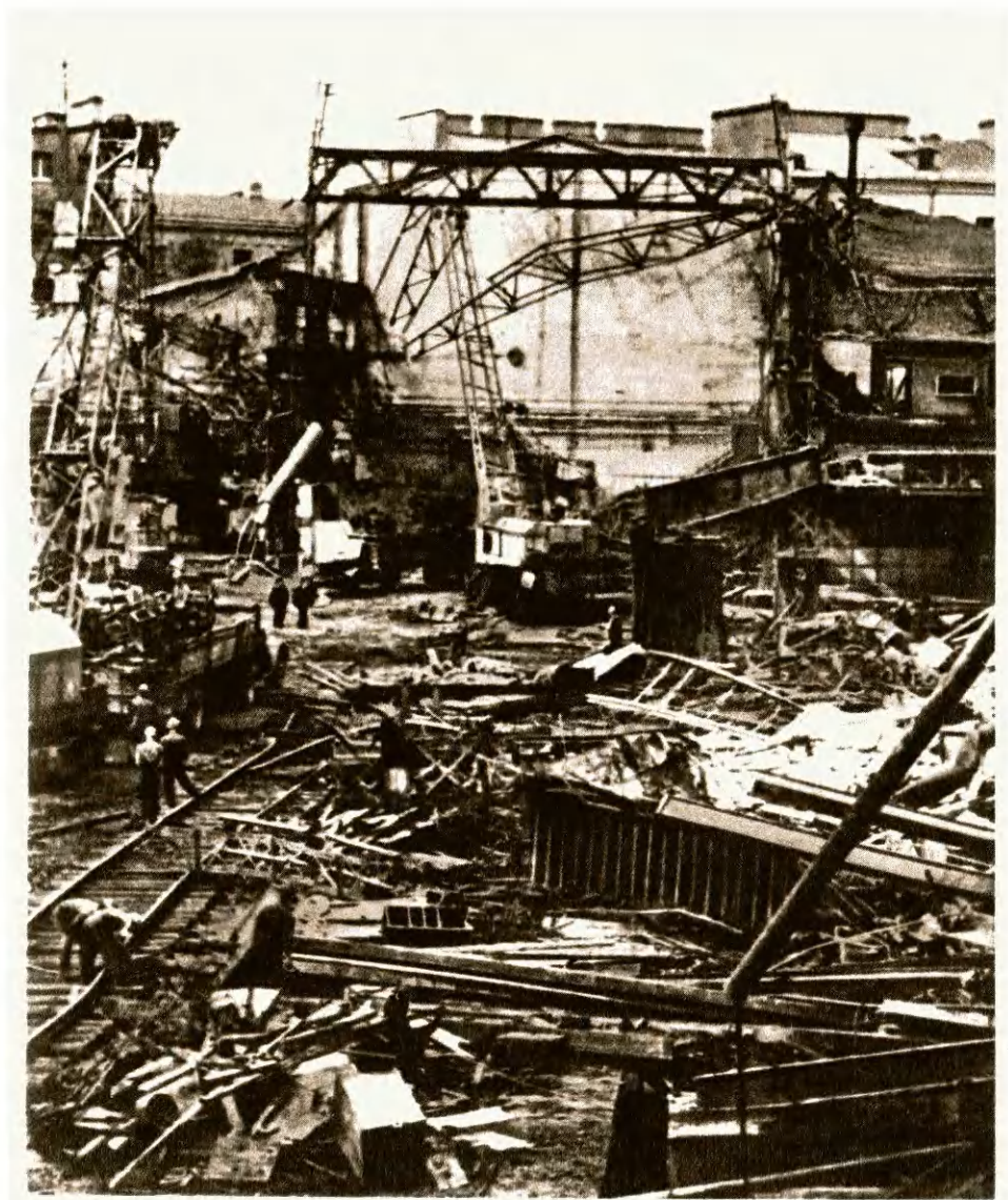
Общий вид разрушенного промышленного здания
