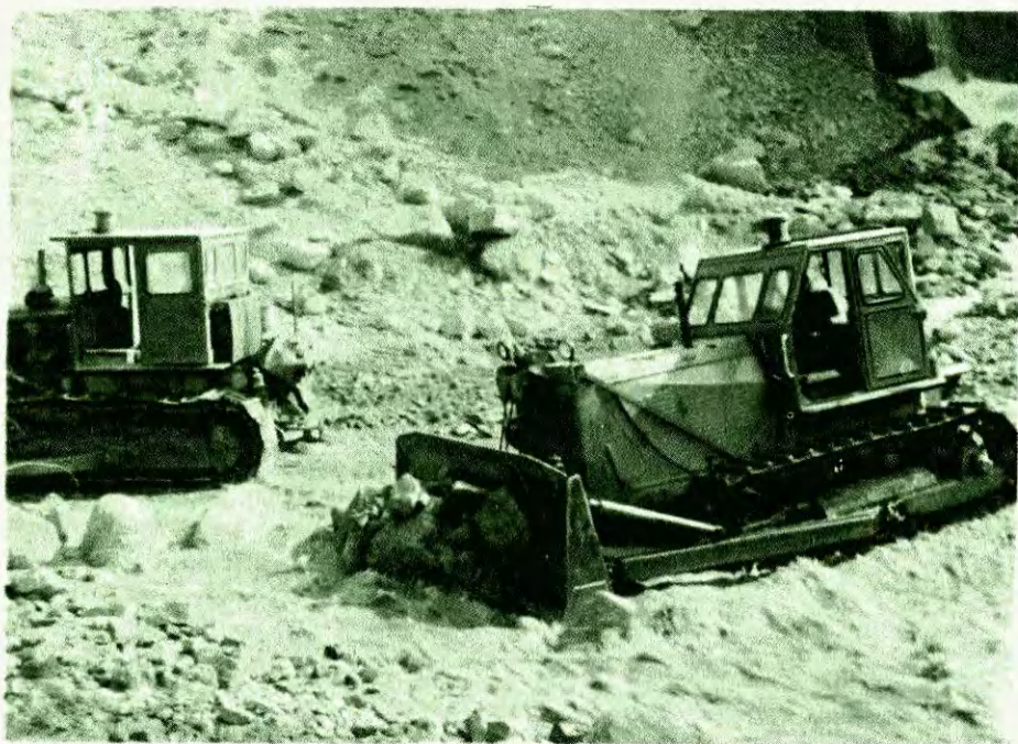
Для расчистки дорог от селевых наносов используют бульдозеры
